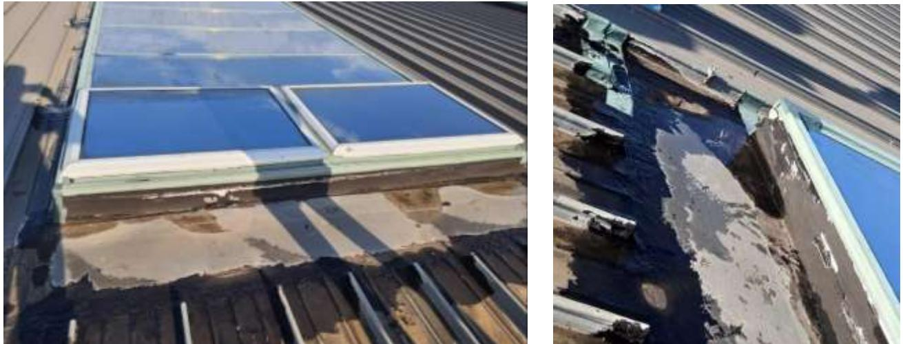
Skica detalja svjetlosne trake-spoj sa krovnim pokrivacem, radjen je na osnovu pregleda svjetlarnika nakon skidanja unutrasnje obloge. Moze se vidijeti da je kriticno mjesto za prolaz vode ispod okapnog lima, a zbog niske visine vijenca. Na pojedinim pozicijama ovaj lim je u kontrapadu-ka profilu.
