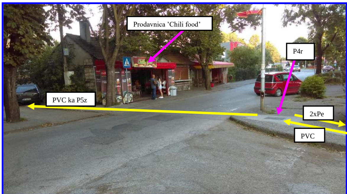
Slika 6: Pozicija postojećeg P4r okna sa pripadajućom kanalizacijom. Slikano prema osnovnoj školi sa kraja zahvata Kraka 1 (Ul. Njegoševa).
