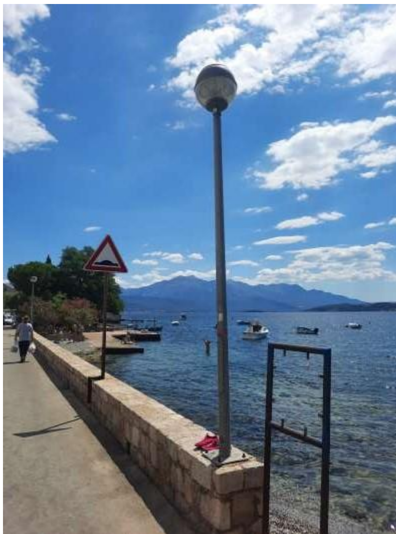
Slika stuba na postojećem kamenom parapetu
