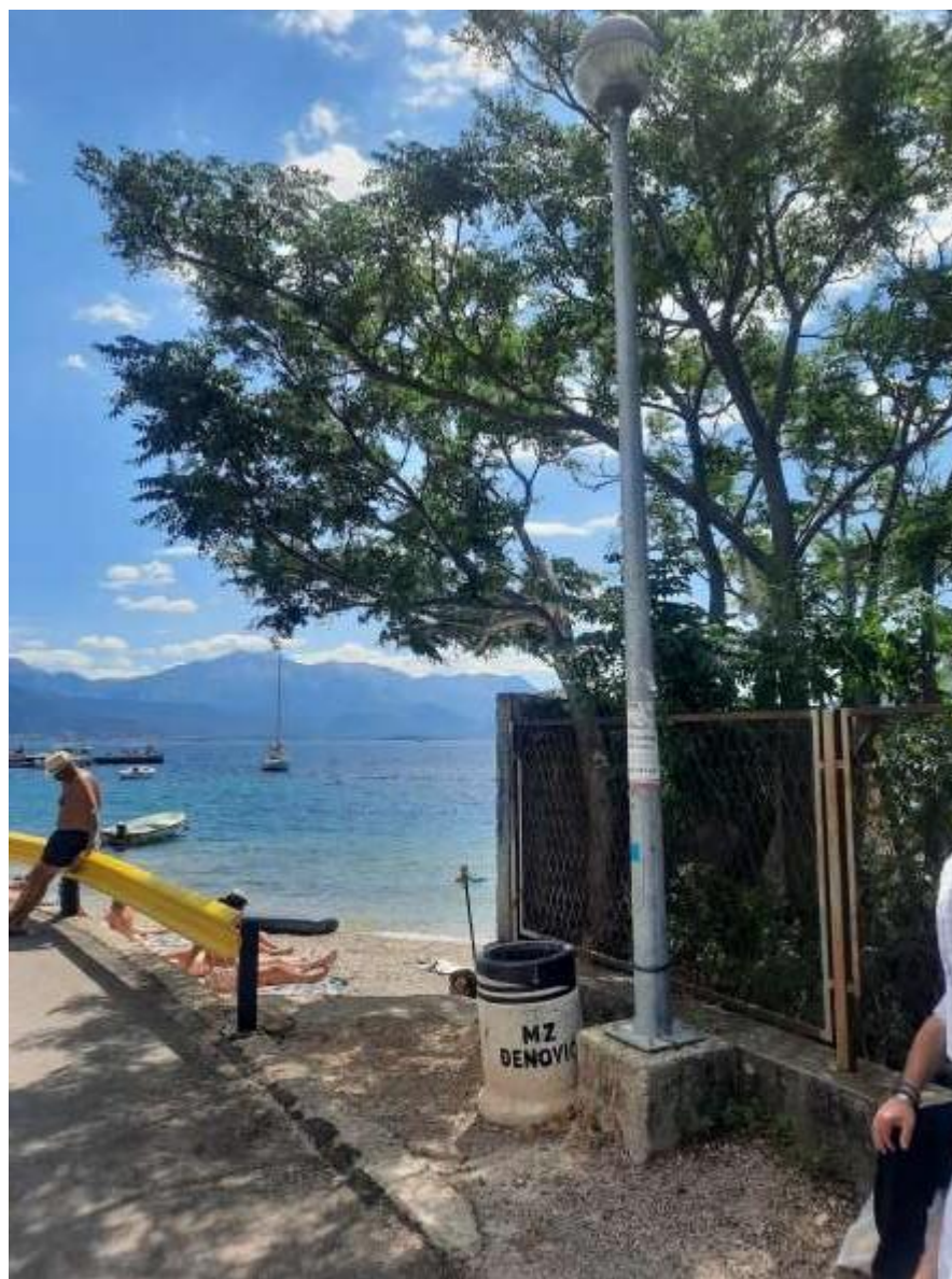
Slika postojećih pocinčanih stubova visine 4 m koji su predviđeni da se vrate na nove temelje.
