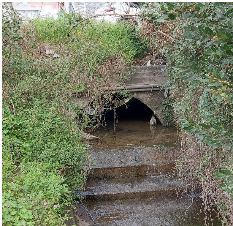
Slika 3: Postojeći propusti duž trase planiranih cjevovoda
