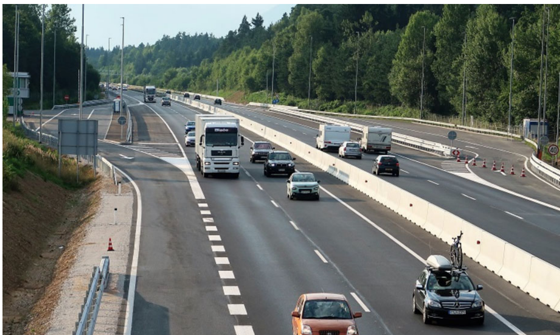
Slika 1. Izgled kontrolnih tački na autoputu
