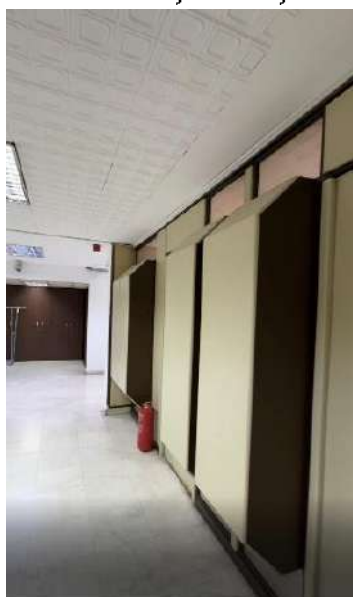
Slika 02: Montažni zid kancelarija
